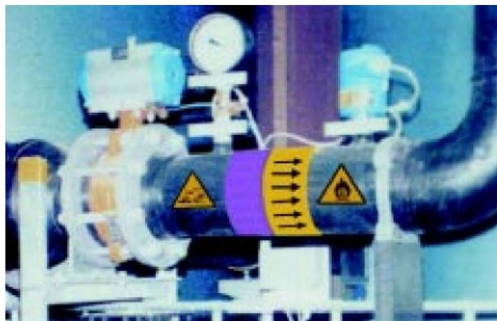
Figura 18: Tubería con fluido identificado según DIN 2403 como gas alcali y paneles de inflamable y corrosivo.
